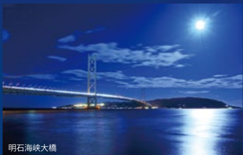
明石海峡大橋
