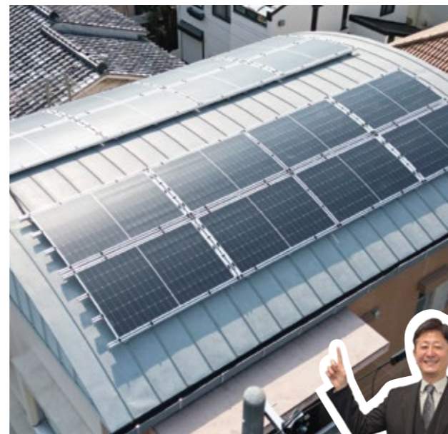
▲兵庫県 M様邸/ガルバニウム鋼板・湾曲屋根・架台工法
